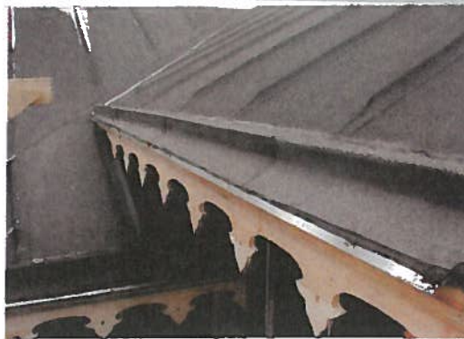
På taket lades en modern svetsbar takpapp. För att efterlikna gamla tjärad papp utan skifferkross i ytan valdes en papp med svart skiffer. Resultatet blir ett tekniskt mycket bra tätskikt som håller i många år. Pappen får förstås inte riktigt samma utseende och det blir inte helle långa rader av pappspik längs alla kanter. Snickarglädjen i takfot had helt enkelt sågats bort och fick rekonstrueras från äldre foton.
